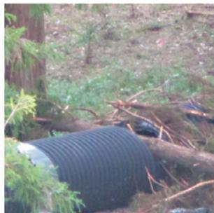
倒木によるケーブル樹脂管破損
