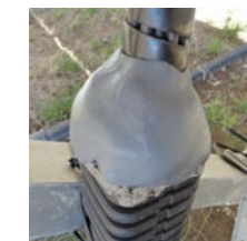
パテ埋め完了
