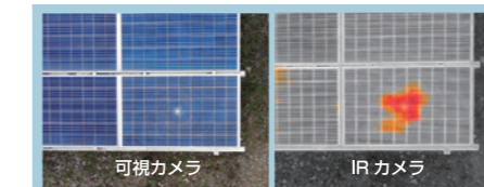
画像1：小型機で撮影したパネル割れ画像
