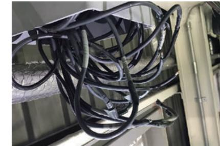
ケーブルは圧着端子により結線されており、断線していた回路は全て**圧着不良が原因で断線**していることが分かりました。
