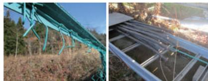
フェンスが壊されており、発電所内の至る所でケーブルラックの蓋が開けられ、ケーブルが切断、持ち去られていたのです。
