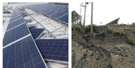
台風によるモジュール飛散
