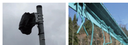
監視カメラに目隠しが... フェンスを破り侵入
