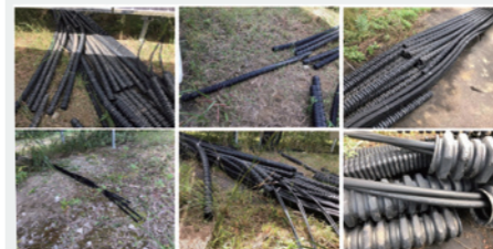
切断された多数の保護配管
