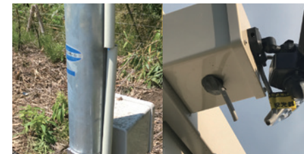
切断された監視カメラやセンサーライトのケーブル
