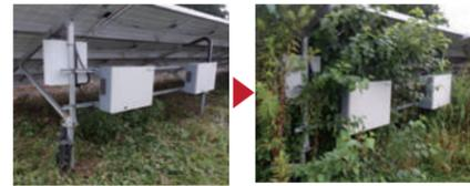
1カ月前に除草したにもかかわらず、翌月には雑草が元のように伸びてしまう太陽光発電所もありました。雑草が生い茂ると発電にも影響しますし、点検作業も行えないので、除草は必要なのですが、その作業の際に電線切断のトラブルが頻発しています。
